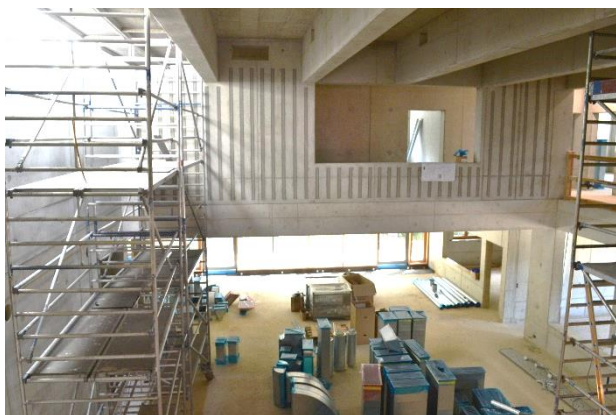
Blick in den Schulneubau/Hausester Weg
