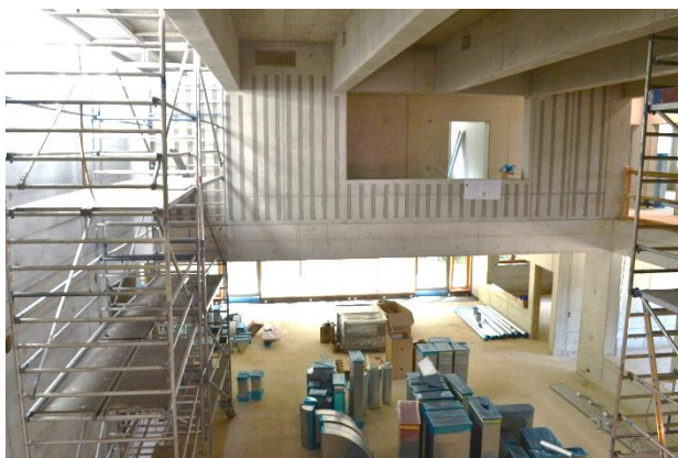
Blick in den Schulneubau/Reimser Straße
